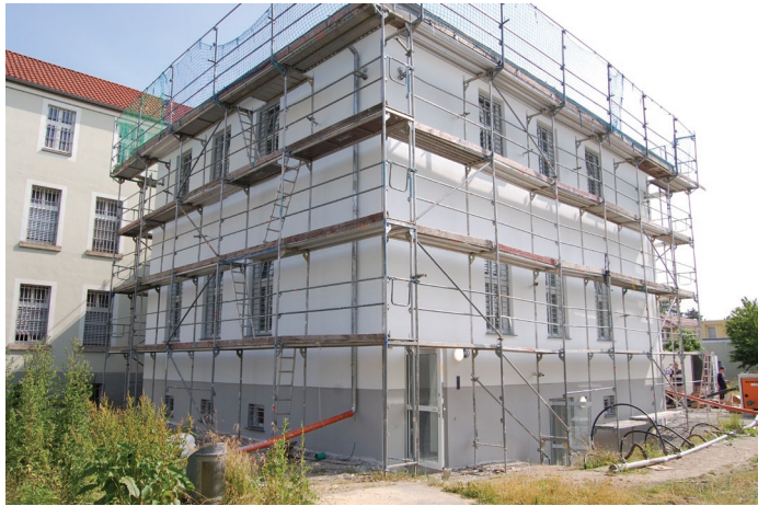
Anbau kurz vor der Fertigstellung im Juni 2023 Foto: LWL/Riepe
