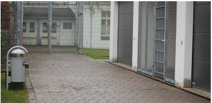
Pflasterweg, der von den Patient:innen hergerichtet wurde. Foto: LWL/Riepe
