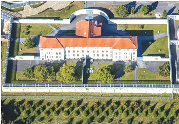
Luftbildaufnahme von Haus 16 vor Baubeginn Foto: Argos
